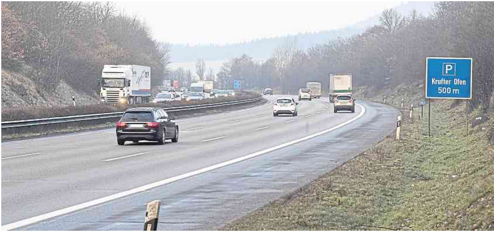
Hier soll ab Mai gebaut werden: Auf der A 61 in Fahrtrichtung Köln wird zwischen Kruft und Mendig die Fahrbahn erneuert.
