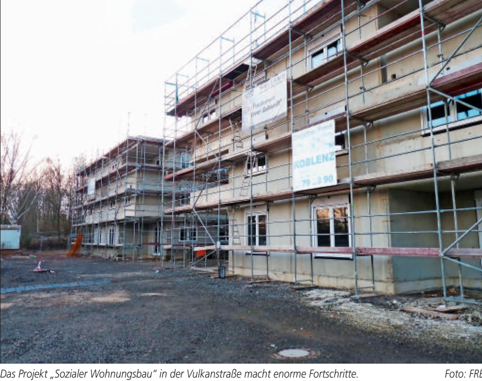
Das Projekt „Sozialer Wohnungsbau“ in der Vulkanstraße macht enorme Fortschritte.
